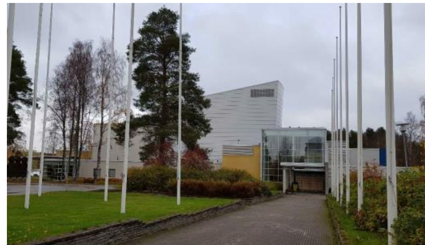
Kuva 16. Kuhmo-talo. (kuva: Kontion koulun rakennushistoriaselvitys, Sweco Finland Oy).
