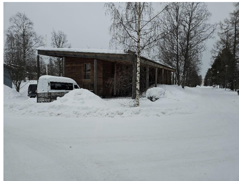
Kuva 14. Kulttuurikeskus Juminkeko. Rakennus on valmistunut vuonna 1999. Sen on suunnitellut arkkitehdit Mikko Heikkinen ja Markku Komonen. 6 Kuvan oikeassa reunassa kulkevan Kontionkadun päätteenä erottuu Tuupalan koulu.
