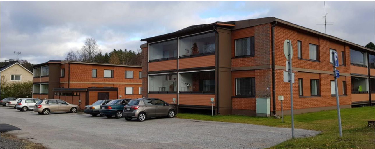
Suunnittelualan reunalla Rajakadun varressa on kaksi kaksikerroksista asuinkerrostaloa. Rakennukset eivät kuulu suunnittelualueeseen.
