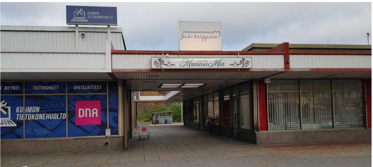
Liikekiinteistön ja linja-autoaseman välissä on katoksen kattama käytävä.
