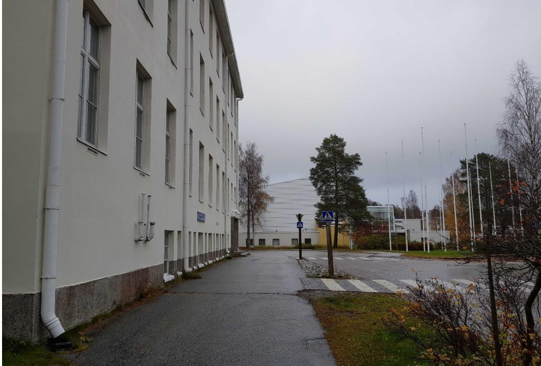
Kontion koulu ja Kuhmo-talo muodostavat Kontionkadun päätteellä erottuvan aluekokonaisuuden.
