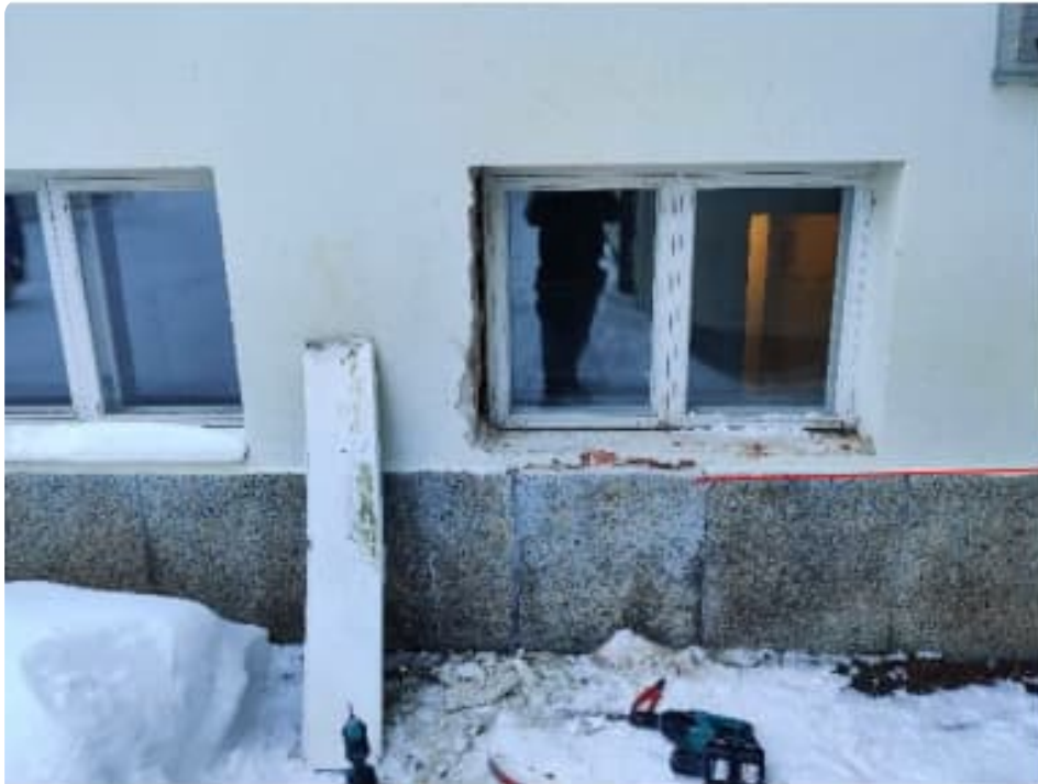
Kuva 62. Rakennetta tutkittiin poistamalla ikkunapelti sisäpihan puolella.
