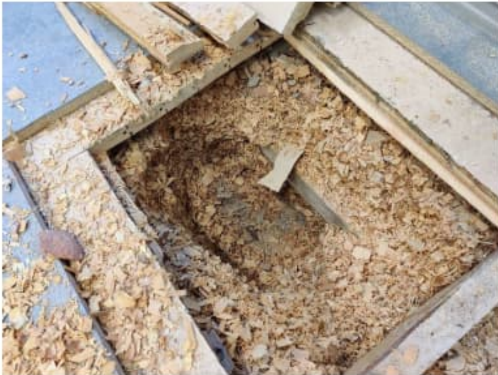
Kuva 37. Eristeenä olevasta kutterinlastusta otettiin sen alaosasta mikrobinäyte VP2 2.1. Myös siinä todettiin selvää mikrobikasvua materiaalissa. VP2.
