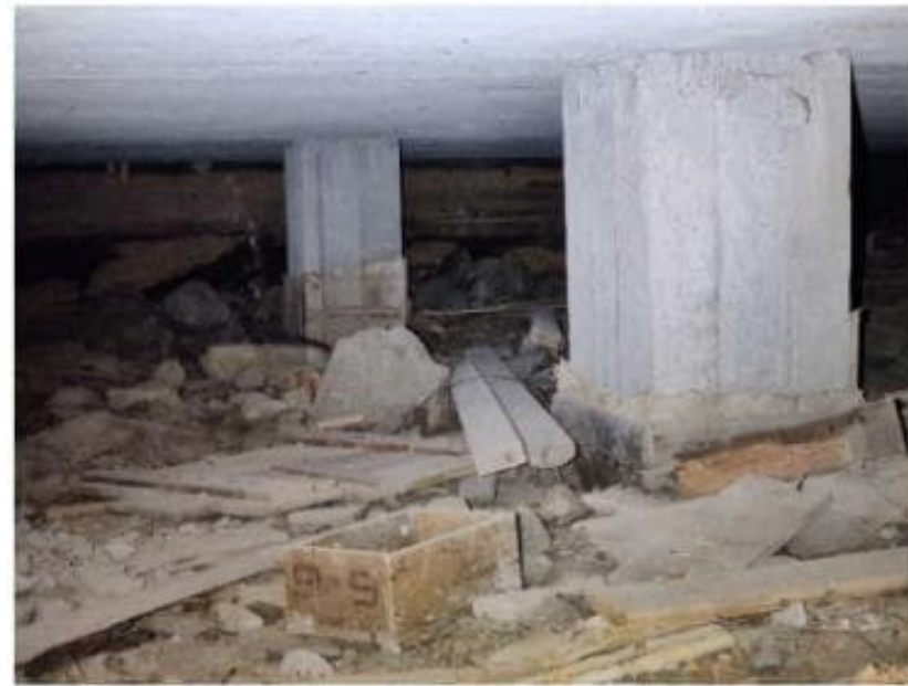
Kuva 11. Yleiskuva ryömintätilasta. Tilassa reilusti orgaanista ainesta kuten lautatavaraa.
