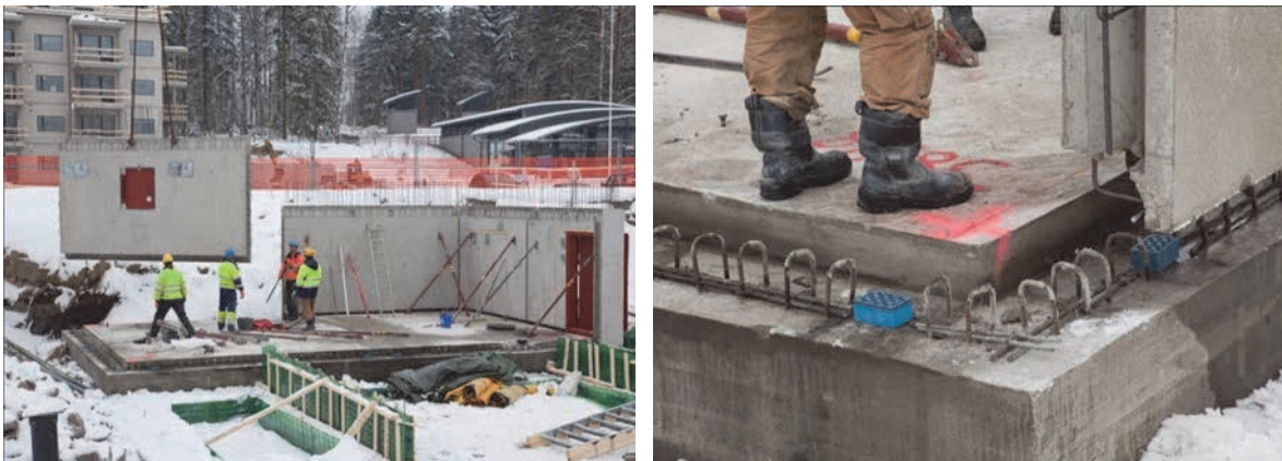
Kuva 10. Nykyisellä tekniikalla tehdyn elementtisuojan asennus, työ kesti 3 päivää.
