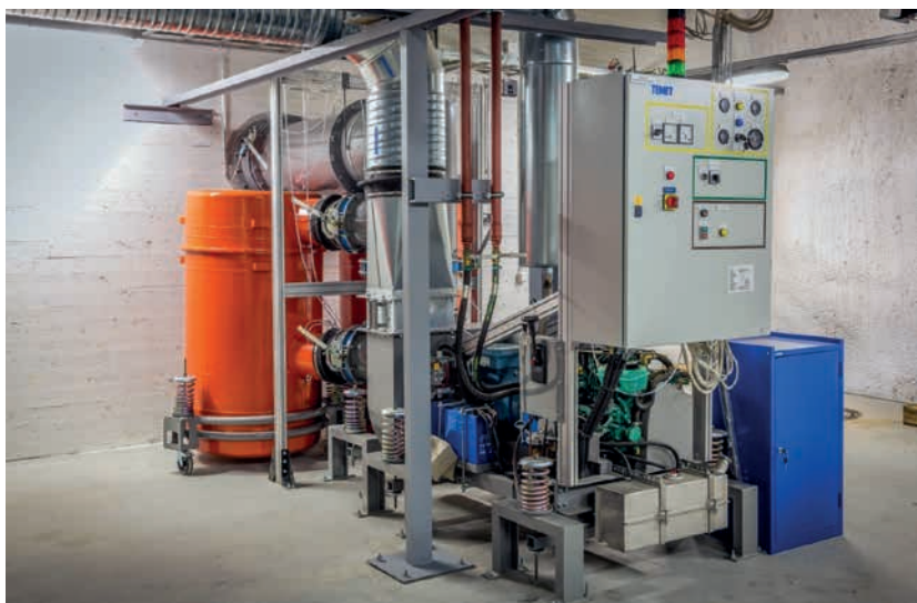
Kuva 31. S2-luokan polttomootorikäyttöinen ilmanvaihtolaitte.
