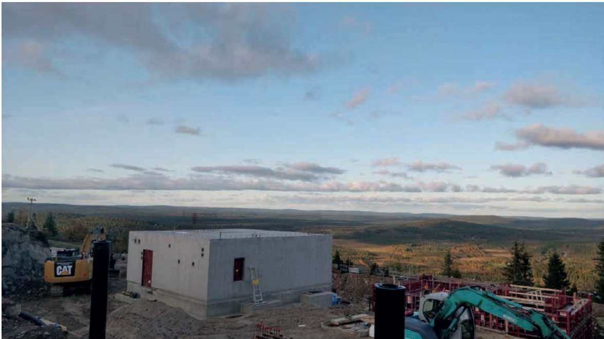
Kuva 4. Paikalla valettu väestönsuoja, jonka rakennusaika on noin 1–2 viikkoa. Kuva A-Perustus Oy.
