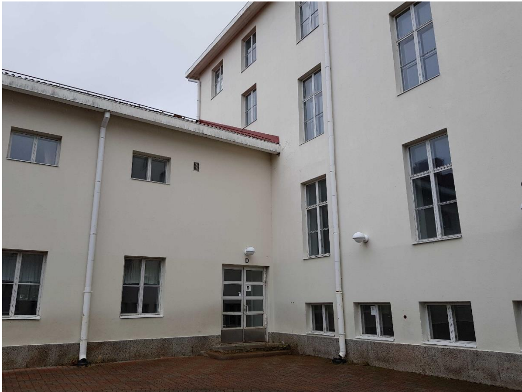
Pääaulaan johtava oppilaiden sisäänkäynti sijaitsee pihan puolella luokkahuonesiiven ja voimistelu- ja juhlasaliin kulmauksessa. Sisäänkäyntiä kehystävät yksinkertaiset, rapatut pielet, oven edessä on porras. Ulko- ovent on uusittu.
