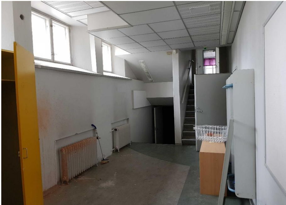
Kellarikerroksen käytävä. Pintamateriaalit ovat vuoden 1990 peruskorjauksen mukaiset.
