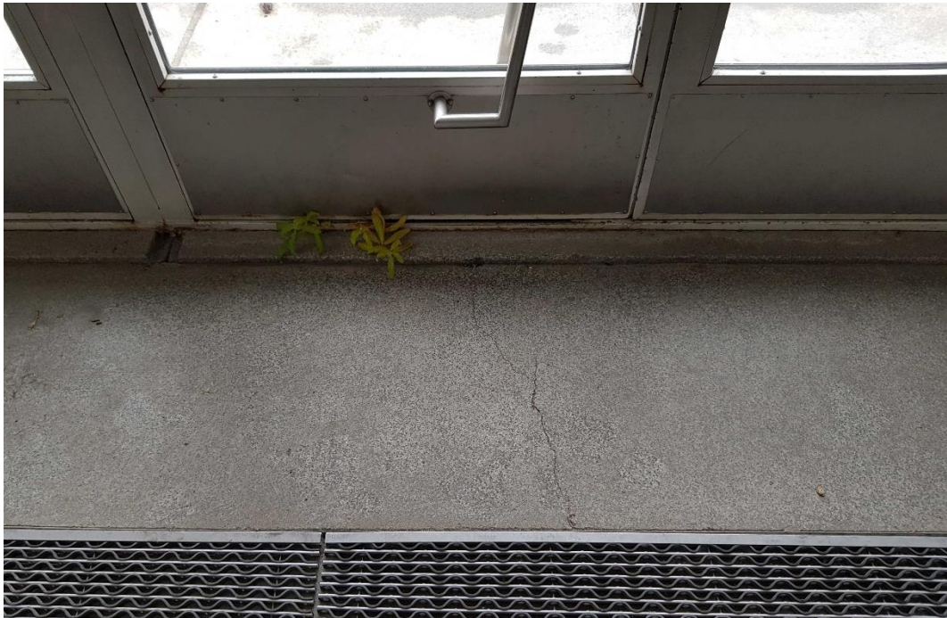
Marmorimosaiikkilattia. Kuramattoa varten lattiaan on tehty listalla rajattu syvennys.
