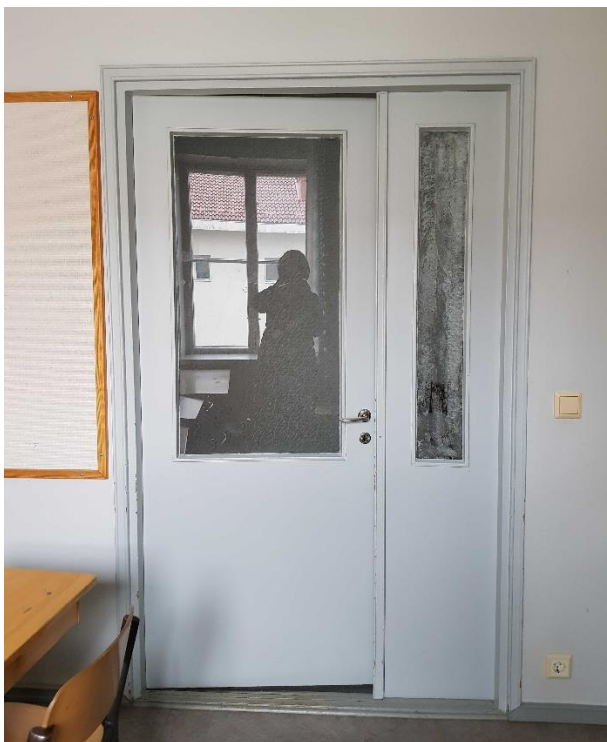
Asumossa ovat säilyneet hallin ja ruokailuhuoneen väliset huurrelaiset ovet.
