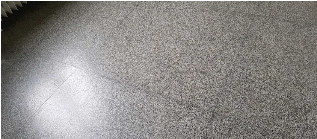
Käytävän marmorimosaiikkilattia on alkuperäinen. Rakennusselityksen mukaan: "Marmorimosaiikkilattiat jaetaan n. 1 m 2 ruutuihin sinkkilistoilla epäsäännöllisen halkeilemisen estämiseksi. ... Marmorimosaiikilla päällystetään kaikki koulun käytävät ja eteiset sekä porrashuoneiden lepotasot ja askeleet." 59
