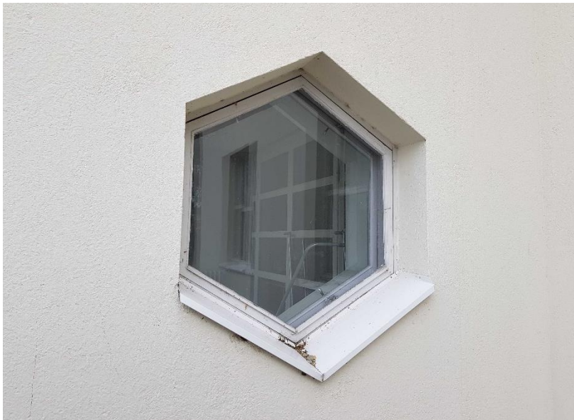
Eteisen kuusikulmainen ikkuna on alkuperäinen. Ulkopuolisia listoituksia lienee korjattu vuoden 1990 peruskorjauksen yhteydessä. Julkisivujen rappauspinnat on peruskorjauksen yhteydessä korjattu vaurioituneilta osiltaan ja maalattu, rappaukset ovat pääosin alkuperäiset.
