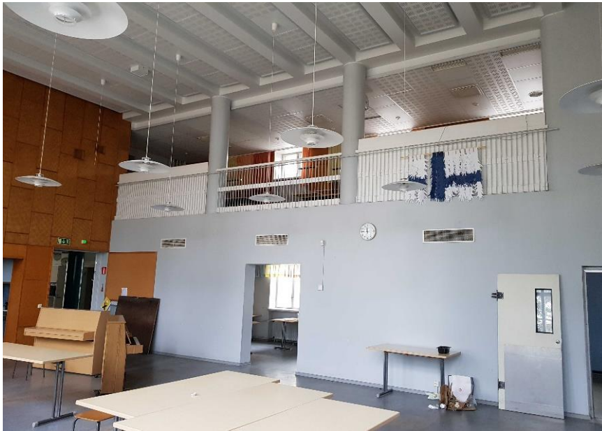
Saliin avautuvalle parvelle on peruskorjauksen yhteydessä suunniteltu ruokailutila. Parven alla sijaitsevat kanslia ja varastotilat on viimeistään peruskorjauksen yhteydessä muutettu ruokailu- ja keittiötiloiksi ja seinään on avattu uusi oviaukko. Seinään on peruskorjauksessa asennettu ilmastointisäleiköt.
