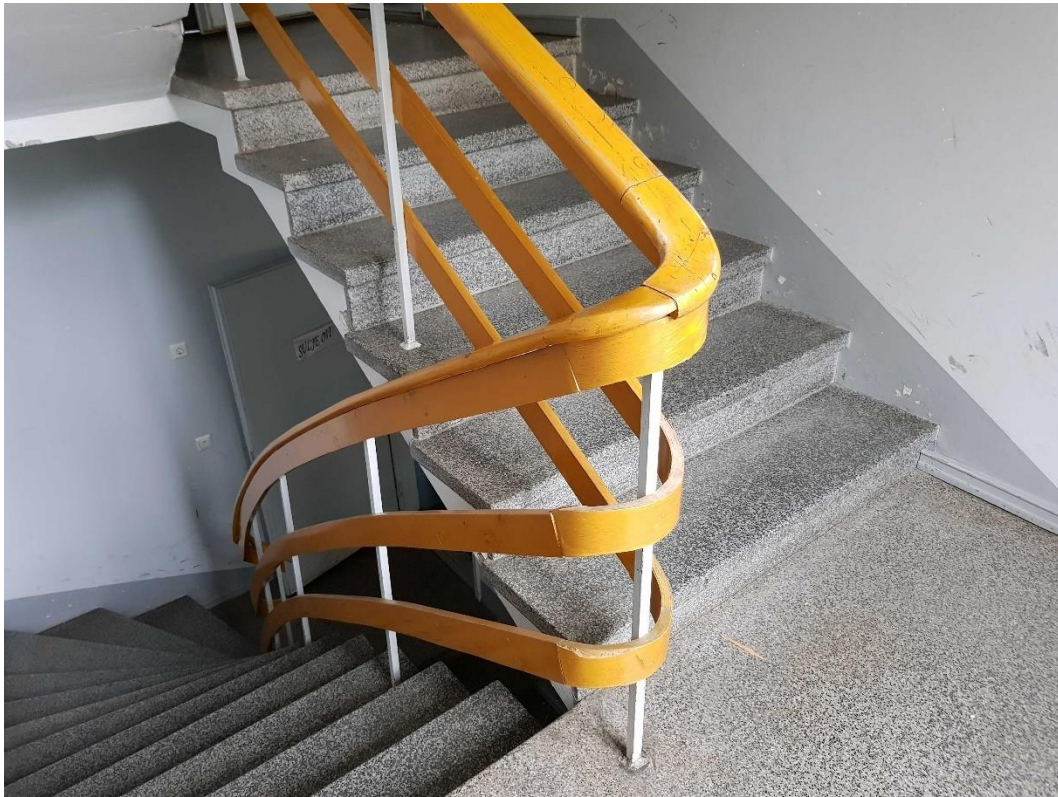
Porraskaide ja portaan mosaiikkibetonipinnat ovat alkuperäiset.
