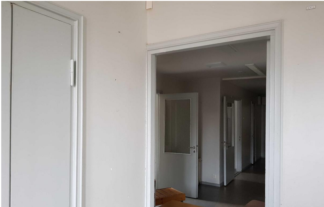
Ovia kehystävät listat ja oletettavasti myös väliovet ovat alkuperäiset. Lattiapinnat on peruskorjauksen yhteydessä uusittu, seinät on maalattu ja kattoon on asennettu akustiikkalevyt.
