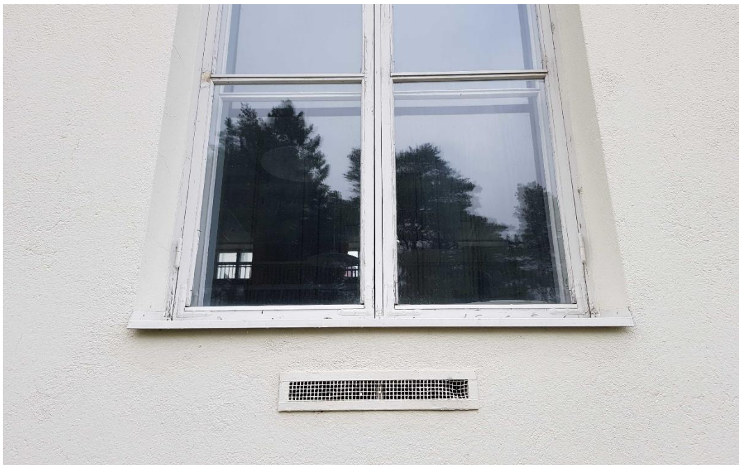
Julkisivussa on venttiilien kohdalla säleiköt.
