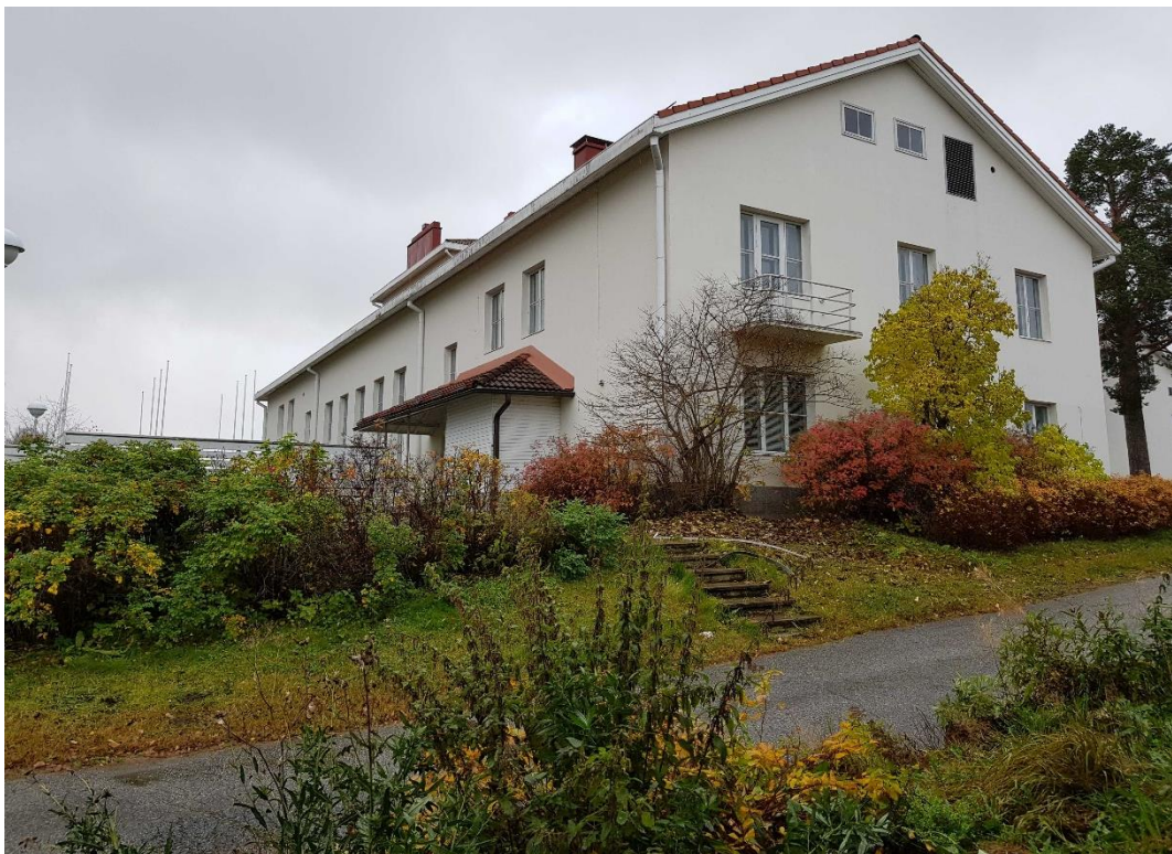
... ja toinen rakennuksen päätyyn. Päädyssä olevalta parvekkeelta on aikanaan ollut näkymä järvelle.
