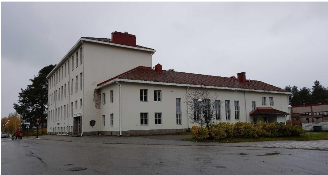
Julkisivu koilliseen, luokkahuonesiipi ja voimistelu- ja juhlasalisiipi. Keittiötiloihin johtavan sisäänkäynnin yhteyteen on rakennettu katos ja lastauslaituri vuonna 1990 toteutetun peruskorjauksen yhteydessä.
