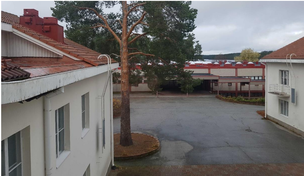
Kolmannen kerroksen käytävältä avautuu näkymiä pihalle ja uudemman koulurakennuksen yli Lammasjärvelle.
