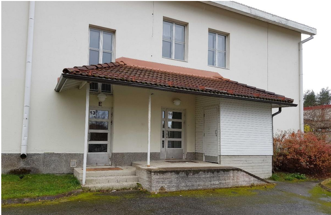
Keittiön sisäänkäynnin eteen on peruskorjauksen yhteydessä tehty lastauslaituri, varastotila ja katos. Vasemmanpuoleinen sisäänkäynti on alkuperäisellä paikalla. Sen kautta on kulku asuntoihin johtavaan porrashuoneeseen. Oikeanpuoleinen sisäänkäynti on tehty ikkunan paikalle vuoden 1990 peruskorjauksessa.
