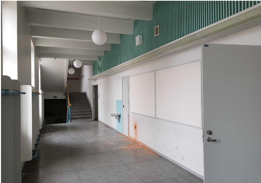
Luokkahuonesiipi, toinen kerros. Seinän yläosassa kotelointia peittävä säleikkö on joka kerroksessa erivärinen. Seinässä näkyy tiilipölyn värjäämä kohta paikassa, josta on otettu rakennenäyte poraamalla rakennusteknistä tutkimusta varten.
