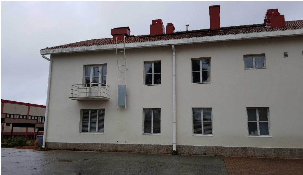
Voimistelu- ja juhlasaliiven päädyssä toisessa kerroksessa sijaitseviin asuntoihin on tehty parvekkeet. Putkikaiteiset parvekkeet ovat alkuperäiset. Toinen parvekkeista avautuu pihan puolelle...
