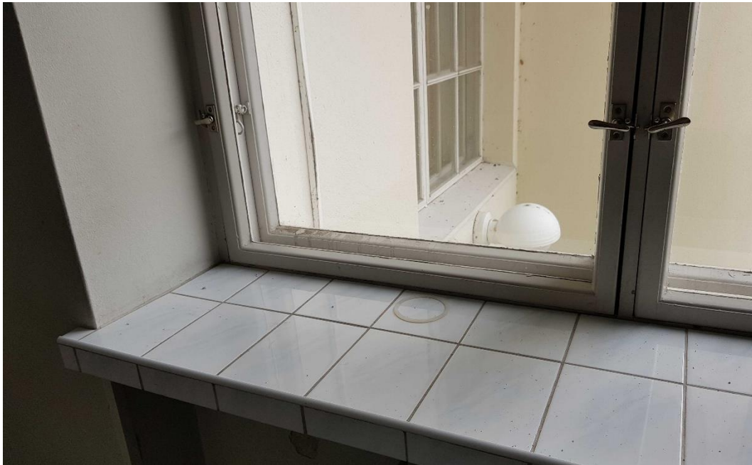
Luokkahuoneiden käytävällä ikkunat ovat alkuperäiset kaksinkertaiset ikkunat. Myös helat ovat alkuperäiset. Ikkunapenkit lienee laatoitettu peruskorjauksen yhteydessä.
