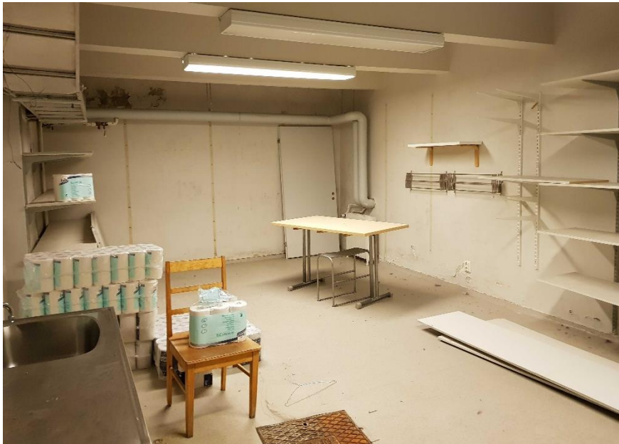
Peruskorjauksen yhteydessä tehty kiinteistönhuoltotila sijaitsee luokkahuonesiiven kellarissa.
