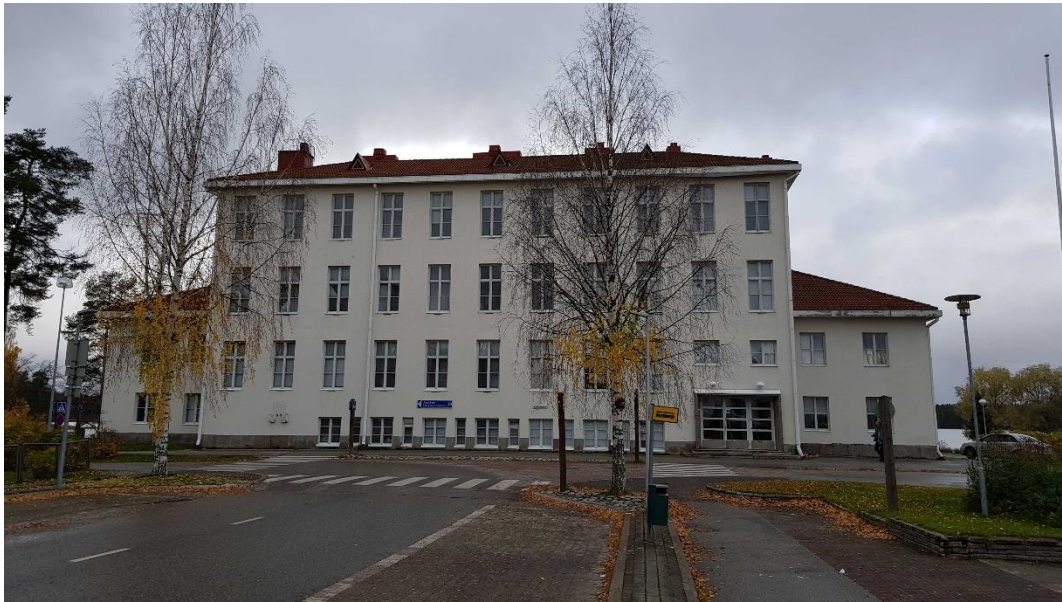
Pääjulkisivu avautuu kaakkoon Kontionkadulle ja Koulukadulle. Rakennus on ulkoasultaan selkeäpiirteinen. Sileiksi rapattu ja julkisivuja rytmittävät tasavälein julkisivulla sijaitsevat kapeat ja korkeat ikkunat. Pääjulkisivulla korostuu Kontionkadun suuntainen nelikerroksinen luokkahuonesiipi.
