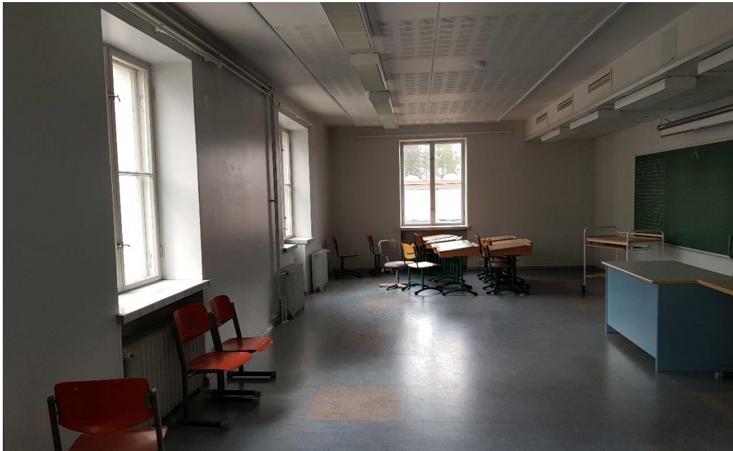
Parven takana sijainneet asuintilat on muutettu peruskorjauksen yhteydessä avoimeksi ruokailutilaksi. Asunnon väliseinät ja keittiö on purettu. Tilaa lienee käytetty myös opetustilana.
