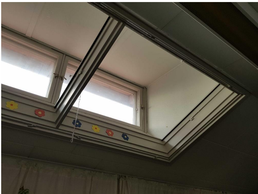
Ullakkokerroksen asunnon käytävään avautuu kattoikkuna.
