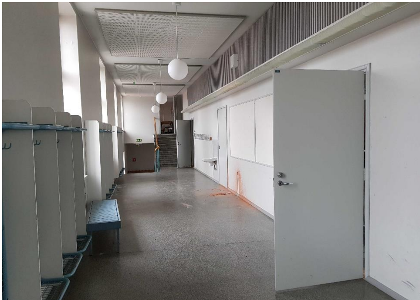
Luokkahuonesiipi, kolmas kerros. Kolmannessa, ylimmässä kerroksessa ei käytävän katossa ole muille kerroksille luonteellomaisia poikkipalkkeja.
