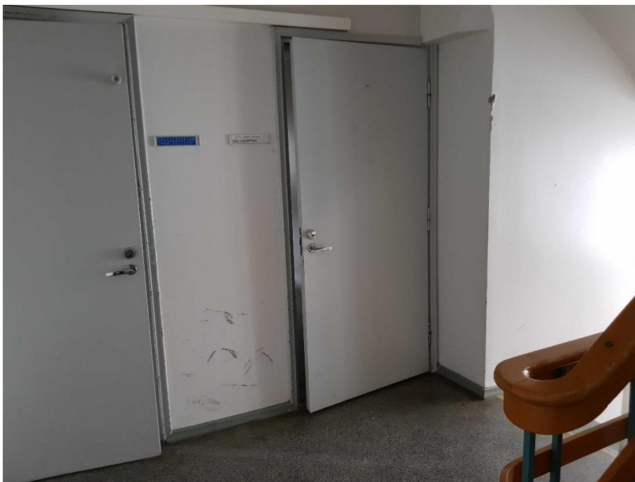
Asuntojen porrashuoneisiin avautuvat ulko-ovet ovat mahdollisesti alkuperäiset, vuoden 1990 peruskorjauksen yhteydessä kunnostetut ja maalatut. Ovia kehystävän alkuperäiset listat. Myös porrashuoneen jalkalistat lienevät alkuperäiset.
