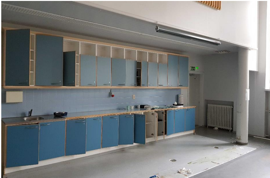
Salin päädyssä sijaitseva jakelukeittiö on rakennettu peruskorjauksen yhteydessä vuonna 1990. Osa kalusteista on purettu pois koulutoiminnan loppumisen jälkeen.
