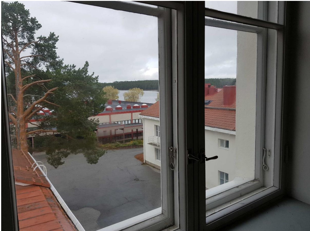
Käytävän ikkunat ovat alkuperäiset.
