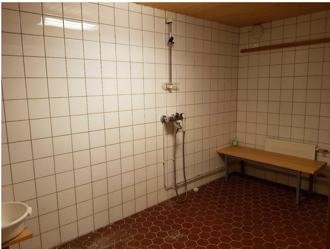
Kellarikäytävän varrella sijaitsevat saunatilat, joihin kuuluvat pukuhuone, pesuhuone ja sauna, on rakennettu leipomon paikalle jo ennen vuoden 1990 peruskorjausta. Pintamateriaaleista päätellen ne on rakennettu 1960-luvulla tai 1970-luvun alussa.
